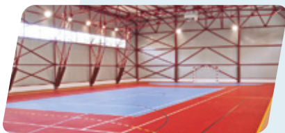
ROMANIA / BAI A MARE LICEUL DE INDUSTRIE, SPORHALLE USOARA LICEUL DE INDUSTRIE, SPORTS HALL USOARA LICEUL DE INDUSTRIE, SALLE DE SPORT USOARA
